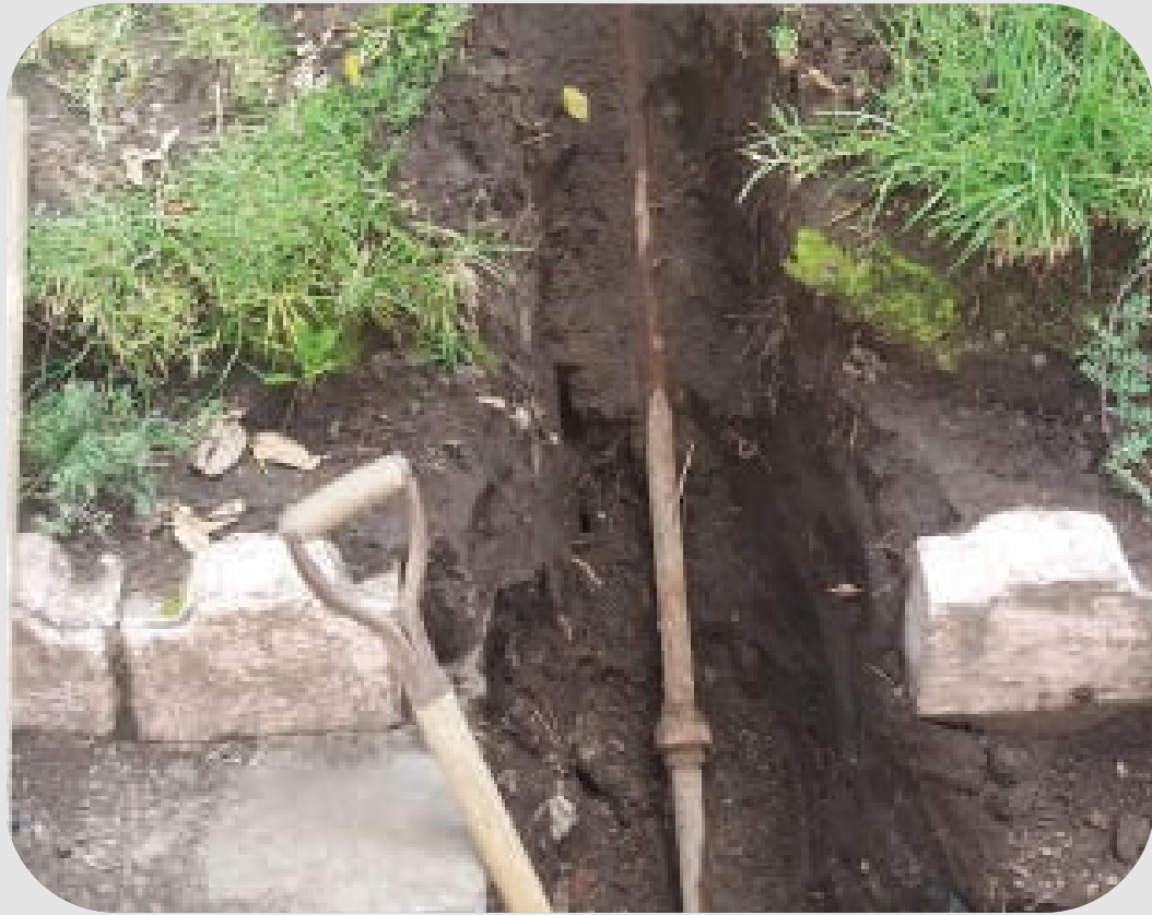
Cambio de tuberías en conjunto.
