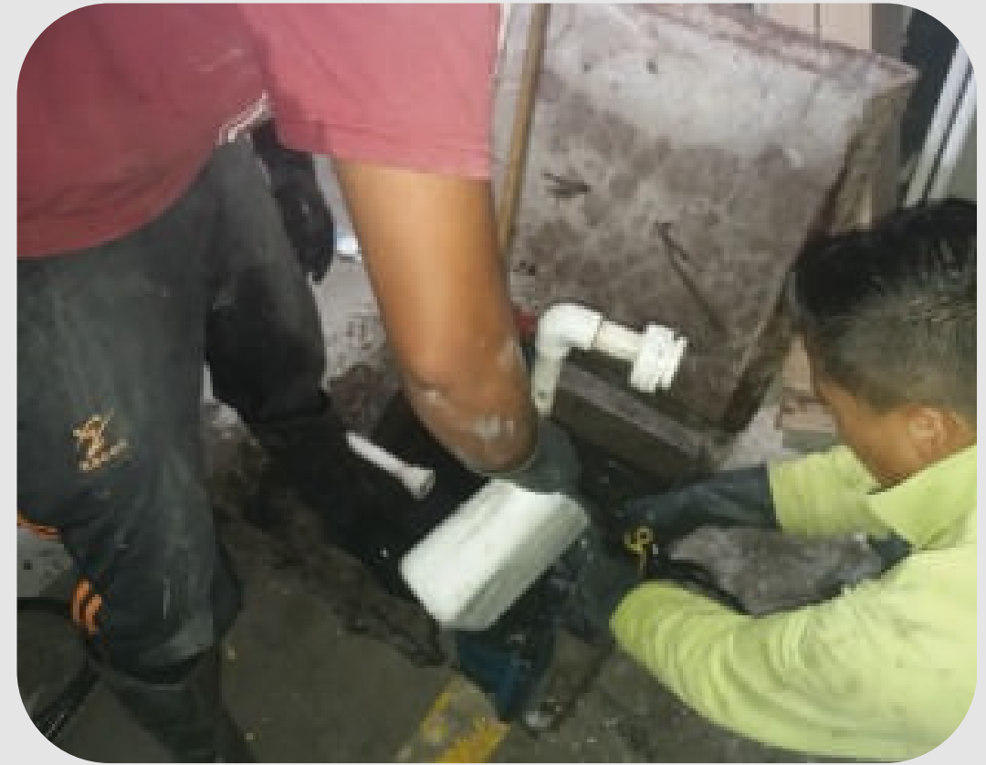
Limpieza de caja con bomba sumergible.
