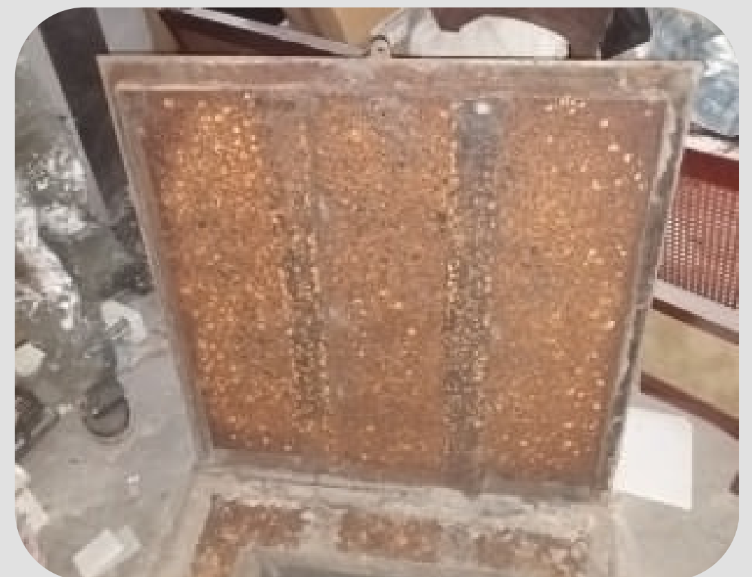
Tapa de cisterna en mal estado.
