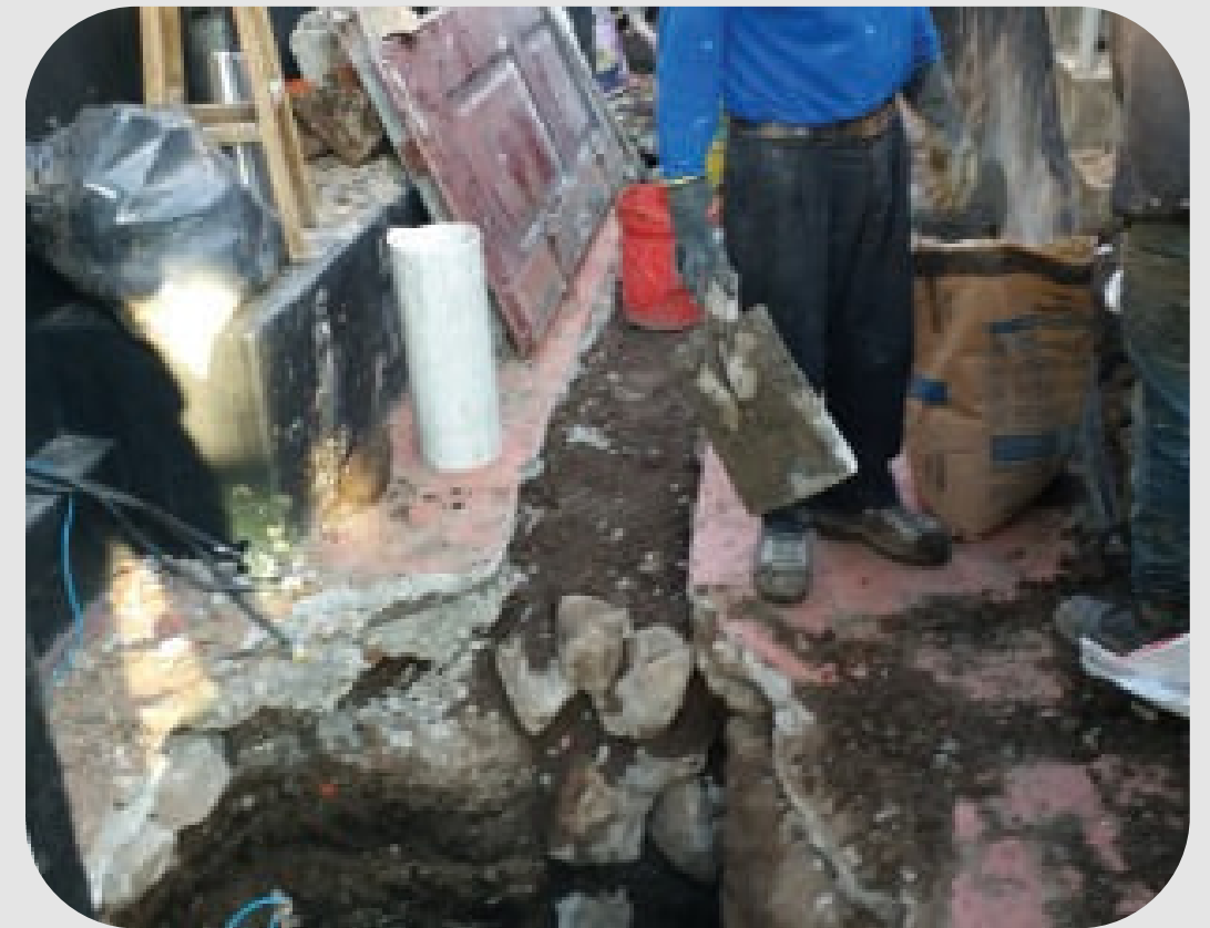
Creación nueva caja de revisión.
