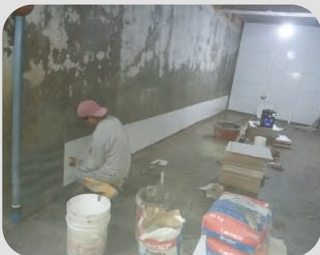
Colocación de cerámica en cisterna.
