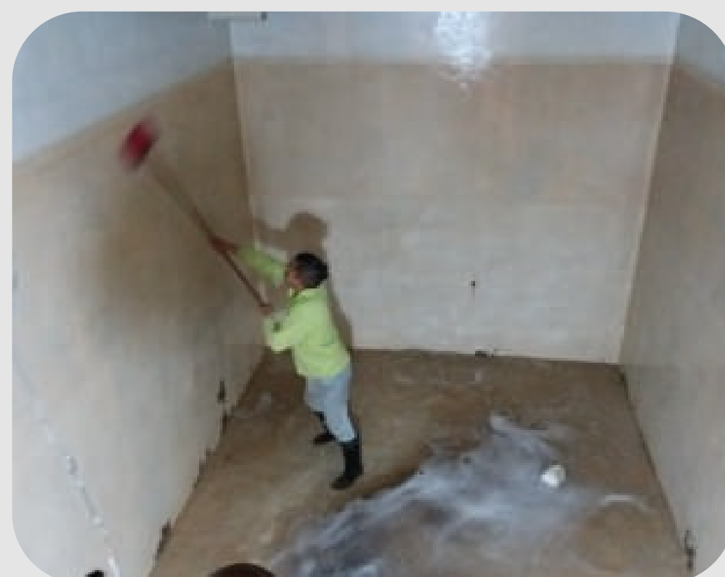
Limpieza y desinfección de paredes en cisterna.
