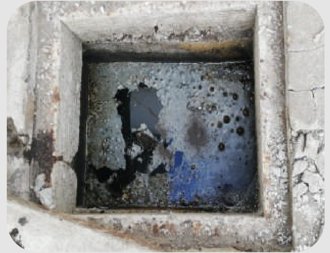
Albañal colapsado.
