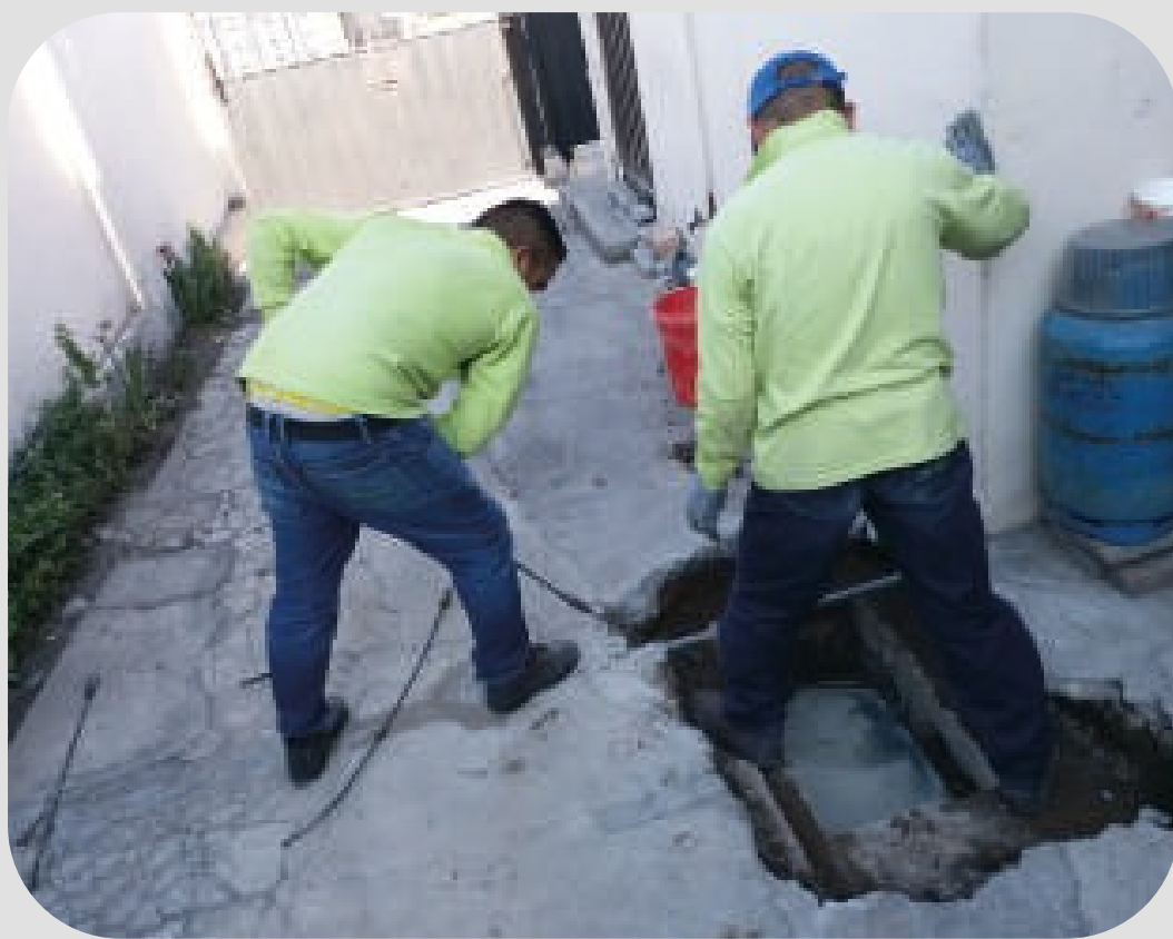
Destape con rotura a la entrada.
