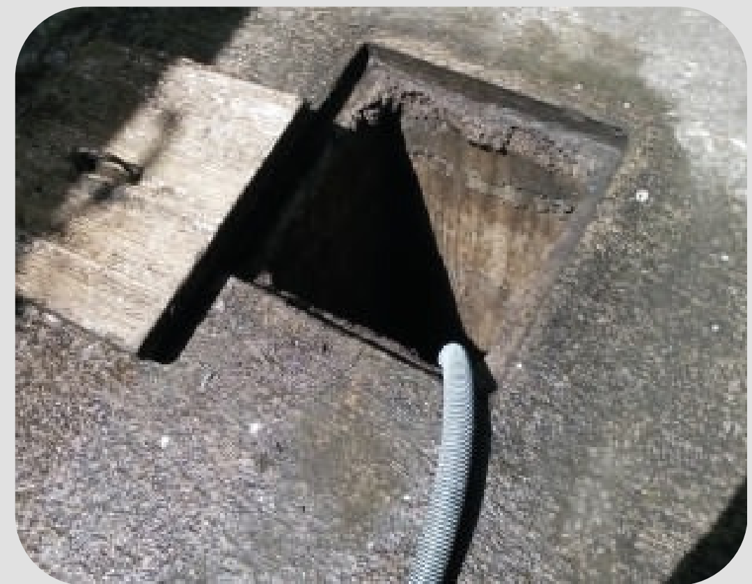
Limpieza con succión caja de revisión.
