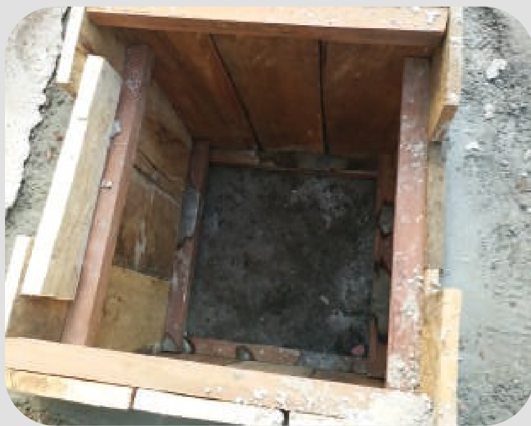
Encoframiento caja de revisión.
